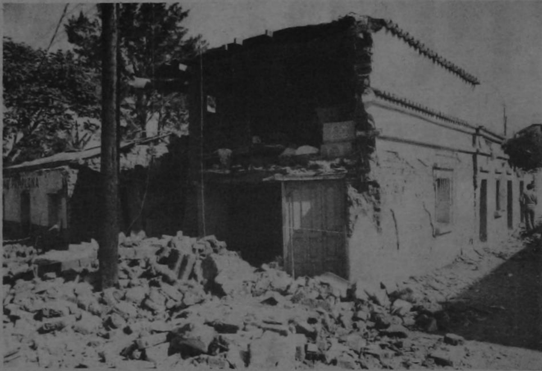
En el piso de arriba una cama, y unas cajas, al borde de la pared que se derrumbó. Abajo un mundo de escombros como todo lo que fue azotado por el violento sismo en la Zona 3 de la Ciudad de Guatemala. (Foto Carlos Morales)
