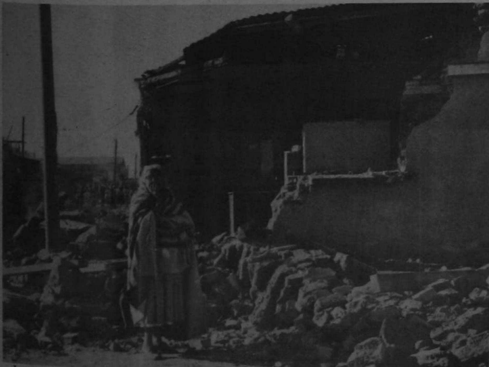
La anciana, desolada, llora calladamente frente a las ruinas de lo que fue su casa de habitación en los alrededores de la Zona 3 de Ciudad de Guatemala. La gente pobre perdió lo único que le quedaba: el techo. (Foto Carlos Morales.)
